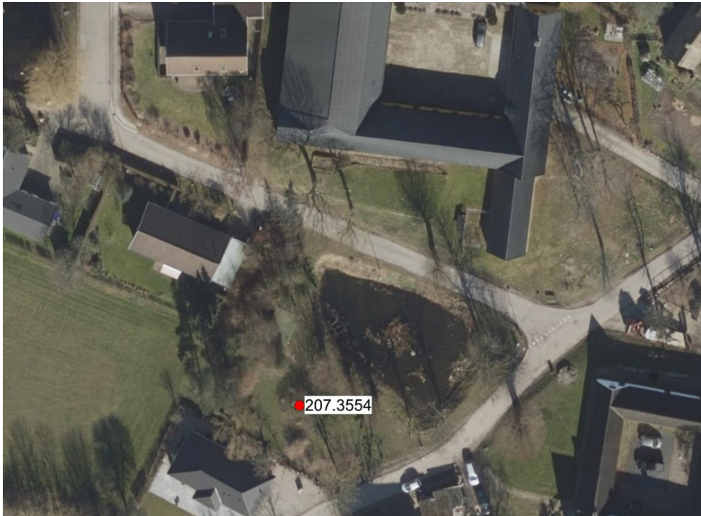
Figur 6-3 Høje Thorstrup vandværk med den aktive boring.
